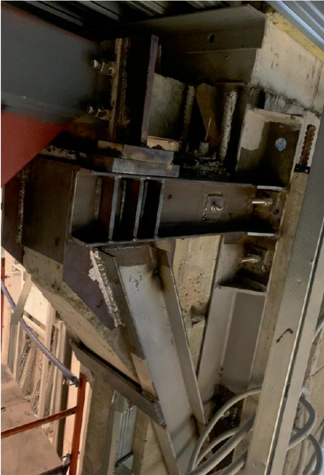
**Рис. 12.** Реализация проектной конструкции усиления коротких консолей железобетонных пилонов
