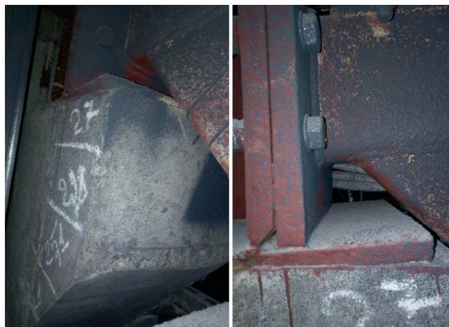
**Рис. 4.** Фактическая конструкция узла опирания стальных ферм на короткие консоли пилонов
