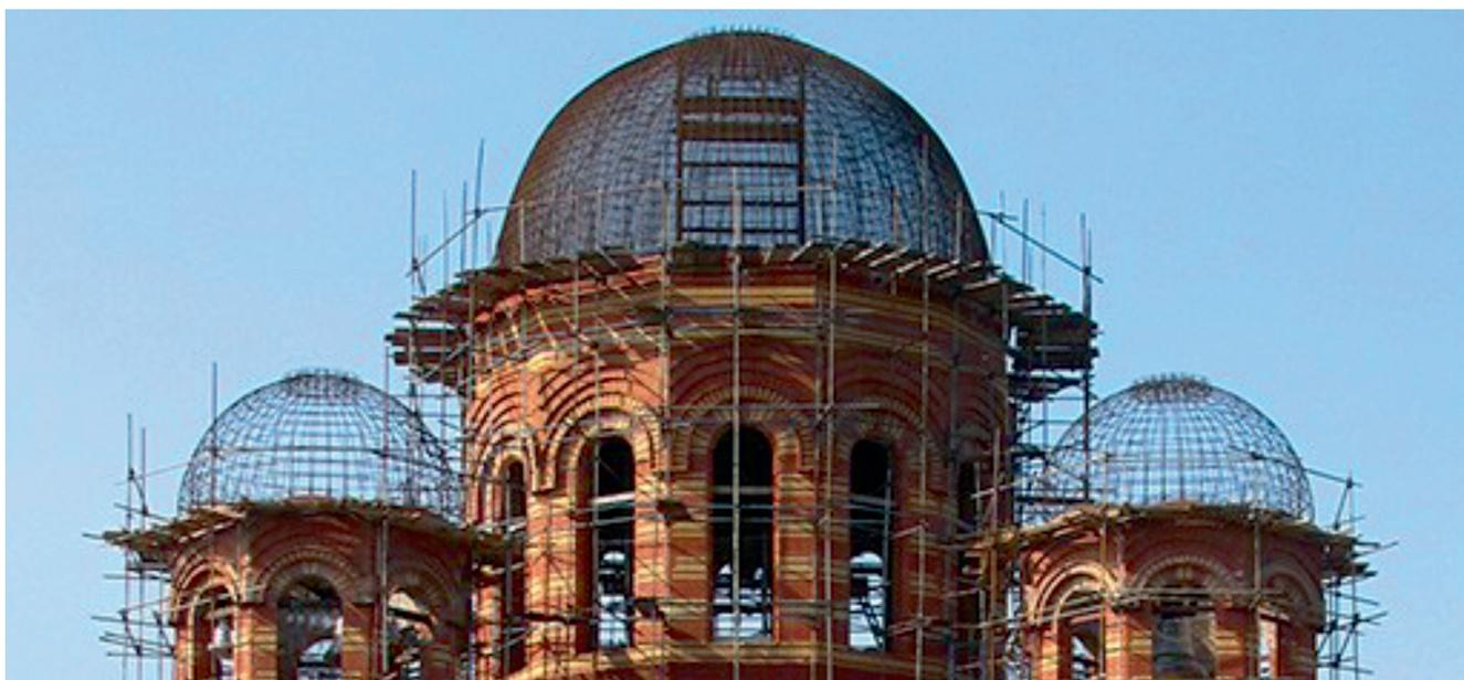
**Рис. 4.** Монтаж арматурных каркасов куполов
