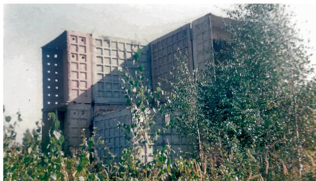
Рис. 1. Фрагмент здания из блок-модулей
