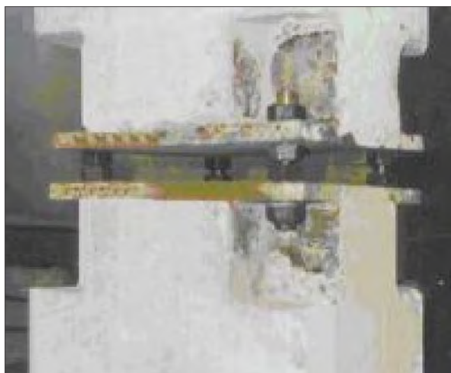
Рис. 4. Новые конструкции стыков колонн повышенной несущей способности с винтовыми соединениями в каркасе «АРКОС» [16] Fig. 4. New designs of joints of columns with increased bearing capacity with screw connections in the «ARKOS» frame [16]
