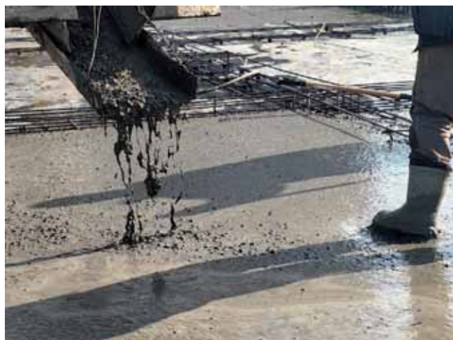
Рис. 2. Процесс бетонирования СФБ плиты (автор фото Маслов П.С.) Fig. 2. Concreting process of the SFRC slab (photo by P.S. Maslov)
