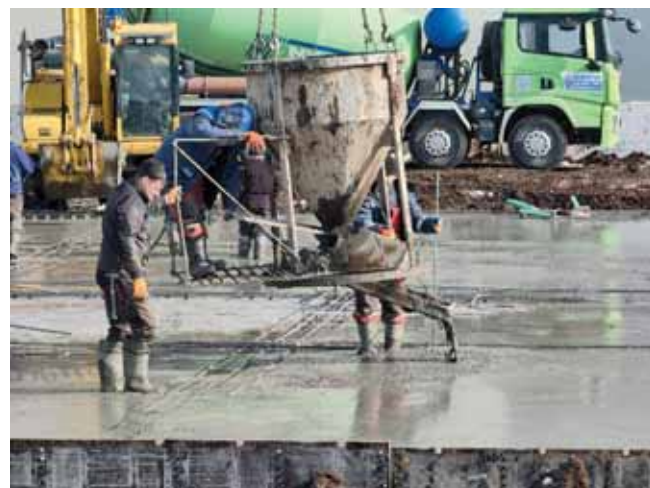
Рис. 2. Процесс бетонирования СФБ плиты (автор фото Маслов П.С.) Fig. 2. Concreting process of the SFRC slab (photo by P.S. Maslov)
