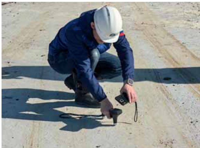
Рис. 3. Процесс контроля прочности бетона (автор фото Маслов П.С.)
