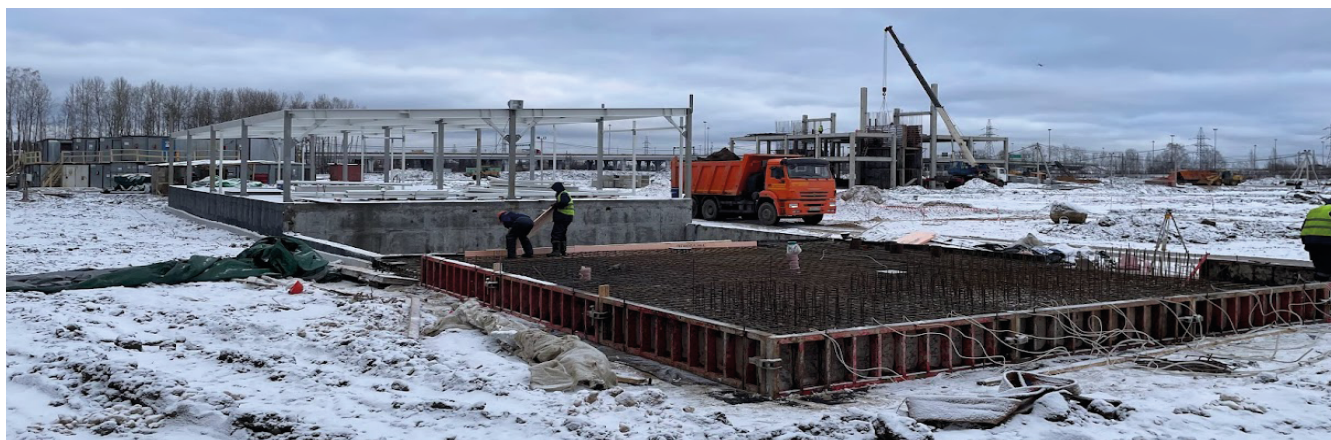
Рис. 4. Эксперимент 4. Фотография сооружения в процессе возведения Fig. 4. Experiment 4. Photograph of the structure in the process of construction
