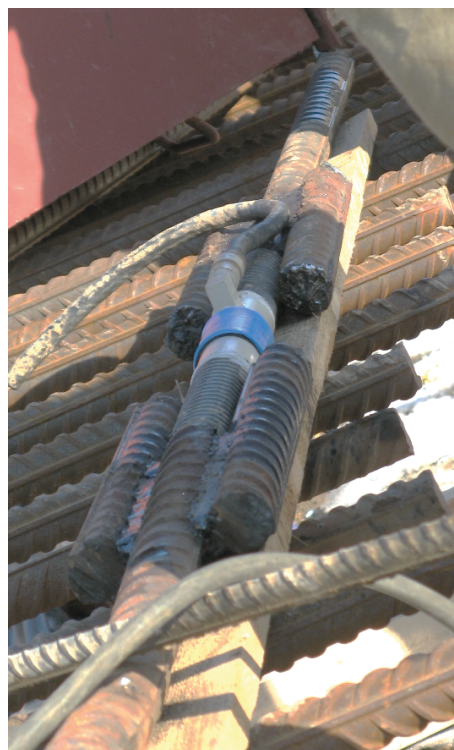
Рис. 11. Пример установки РСАС на рабочую арматуру в фундаментной плите
