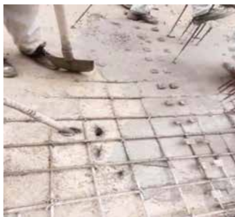
Рис. 6. Вибропобуждение уложенной бетонной смеси за пределами границ сохранения удобоукладываемости Fig. 6. Vibration sealing of the laid concrete mix beyond the boundaries of the preservation of workability
