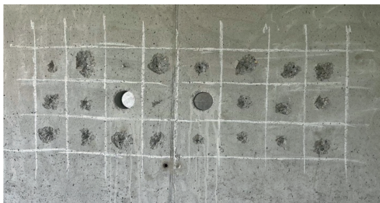
Рис. 2. Стена после выбуривания кернов и извлечения дюбель-гвоздей
