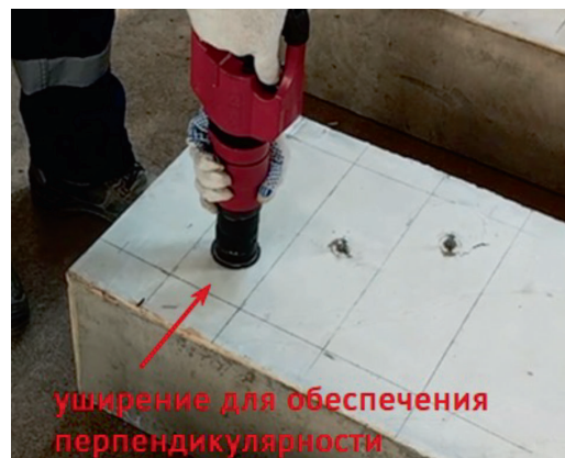
Рис. 3. Установка дюбель-гвоздей с помощью пистолета GFT 5
