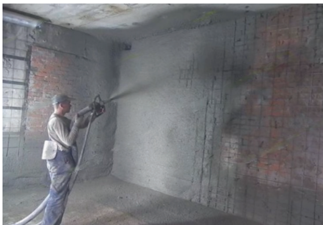
Рис. 11. Торкрет-бетонирование по металлической сетке кирпичной стены Fig. 11. Concrete shotcreting over metal mesh of a brick wall
