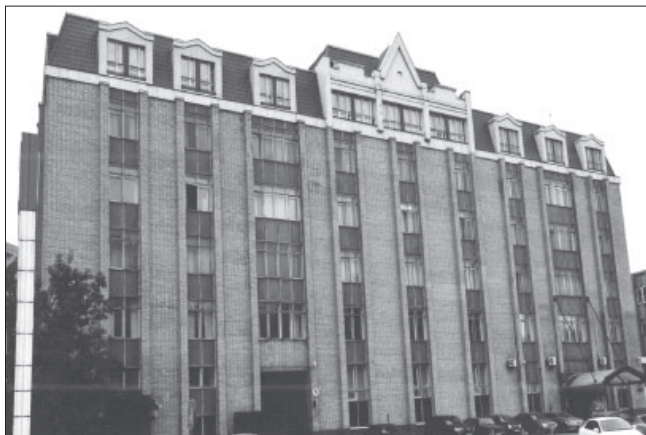
Здание института «ВНИИЖелезобетон» (Москва, ул. Плеханова, 7)
