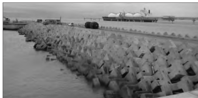
Рис. 3. Берегоукрепление корневой части пирса фасонными массивами (гексабитами) (объект К3-1, табл. 1)
