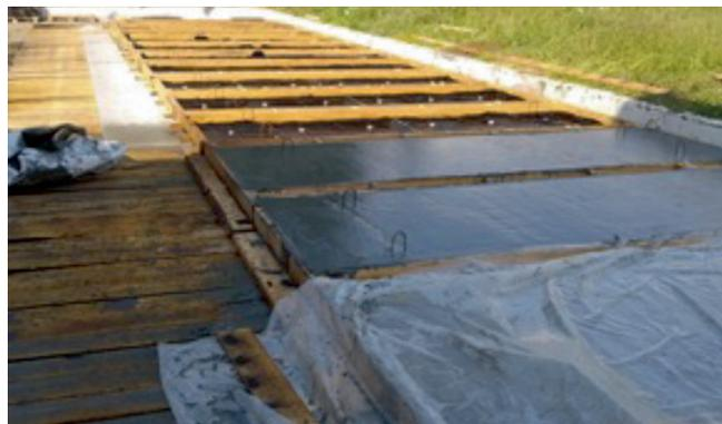
**Рис. 1.** Фрагмент процесса изготовления натуральных плит на площадке НИЭЦ «Стройтест»
