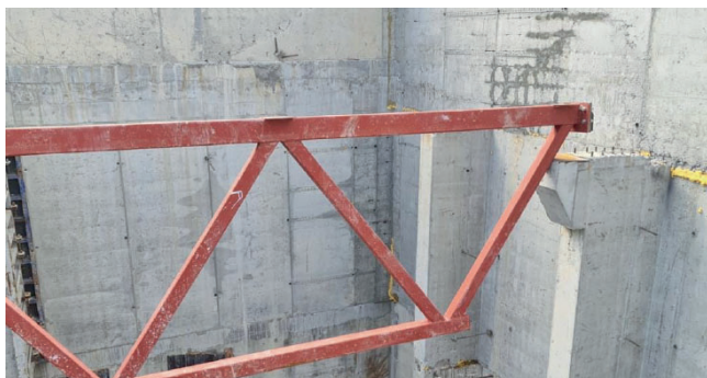
Рис. 5. Фотофиксация монтажа стальной фермы (а) с демонстрацией опорной части фермы (б), не вписывающейся в проектные размеры узла опирания на короткие консоли пилонов
