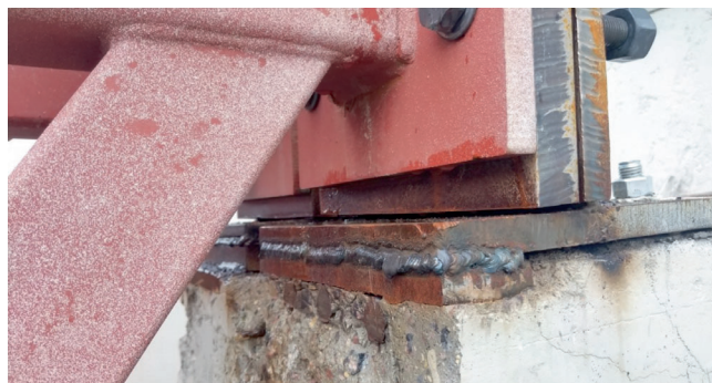
Рис. 6. Пример конструкции узла опирания стальных ферм на срезанные участки коротких консолей пилонов
