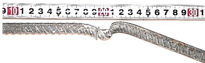
Рис. 3. Стержень-упор модели М3 (арматура \varnothing 12 А500С) Fig. 3. Reinforced concrete dowels for model M3 (reinforcement \varnothing 12 А500С)
