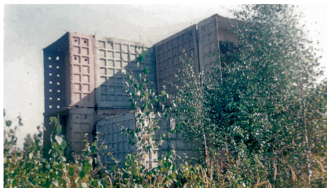
Рис. 1. Фрагмент здания из блок-модулей
