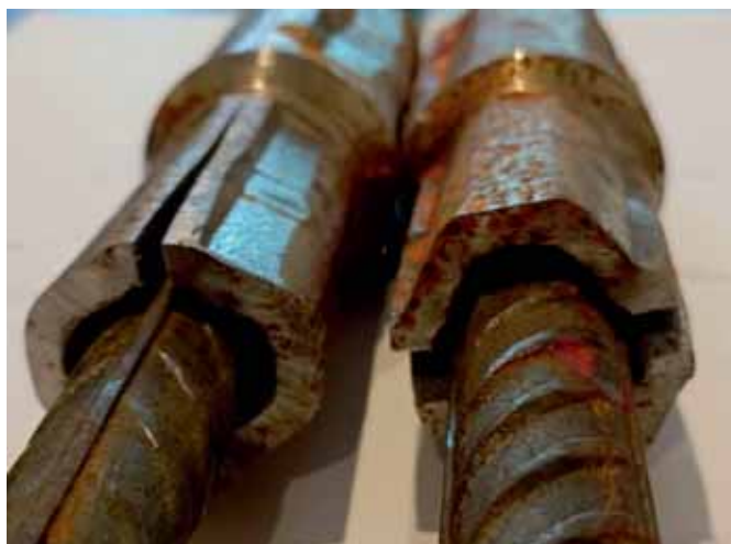
Рис. 14. Разрушение опрессованного муфтового соединения от расклинивающего эффекта арматуры с двухсторонним расположением поперечных ребер
