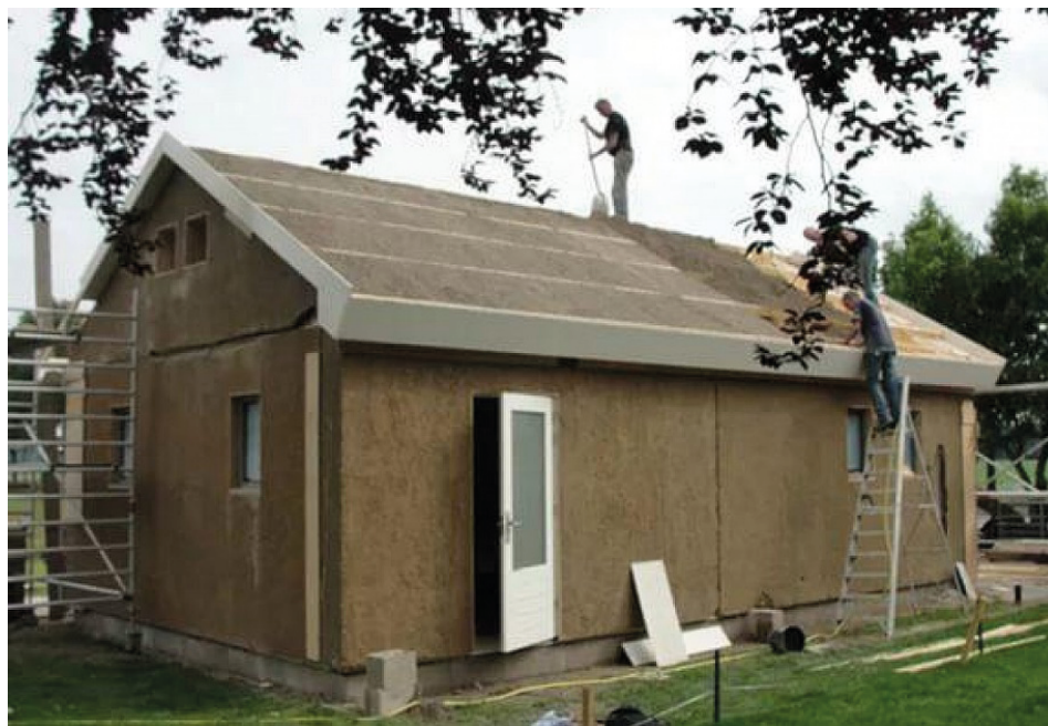
Рис. 2. Строеие из костробетона (интернет-источник: https://admin.business-platform.ru/storage/110624/conversions/gallery-smi4d8-large.jpg ) Fig. 2. Hempcrete structure (online source: https://admin.business-platform.ru/storage/110624/conversions/gallery-smi4d8-large.jpg )
