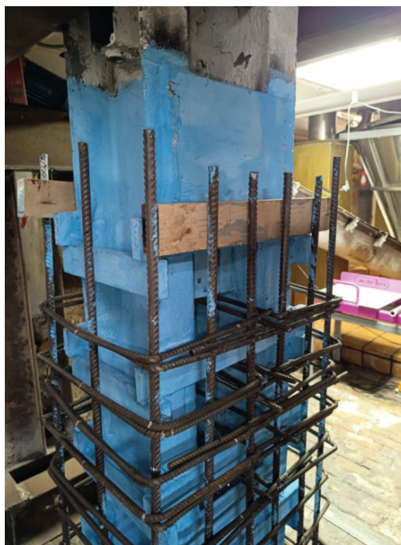
Рис. 7. Общий вид конструкций усиления перед установкой опалубки Fig. 7. General view of reinforcement structures before formwork installation
