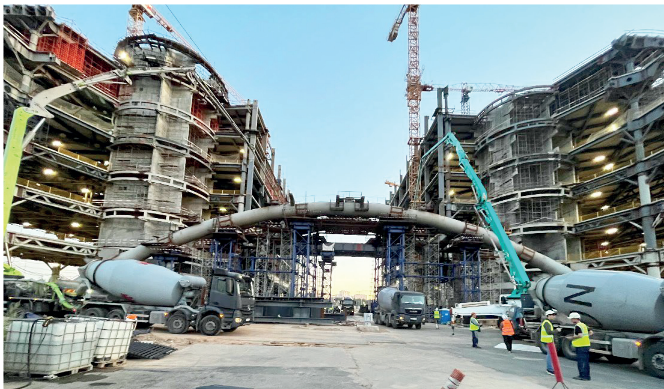
Рис. 9. Процесс бетонирования центральной части сталежелезобетонной конструкции арки методом «сверху вниз»
