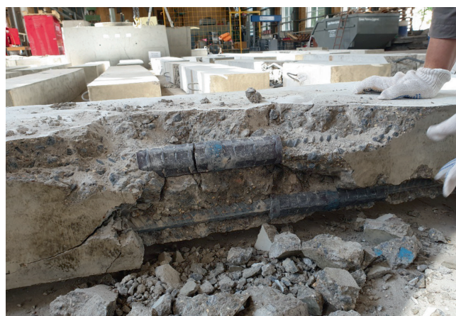
Рис. 3. Разборка нижней грани опытного образца Б.32.24.1 с разрушенной муфтой Fig. 3. Disassembly of the lower face of the Б.32.24.1 prototype with a destroyed coupling
