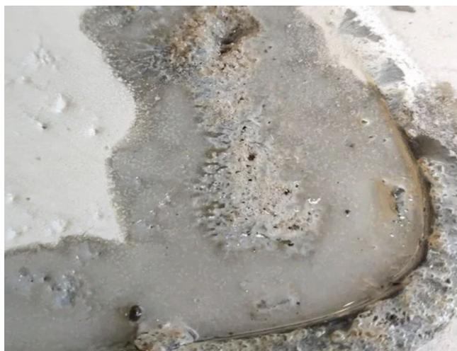
Рис. 8. Место протечки. Примыкание шпонки к бетону
