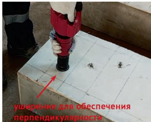
**Рис. 3.** Установка дюбель-гвоздей с помощью пистолета GFT 5
