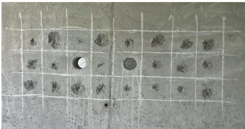
**Рис. 2.** Стена после выбуривания кернов и извлечения дюбель-гвоздей
