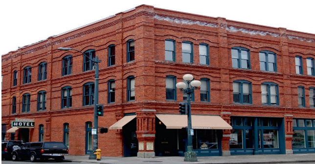
Рис. 12. Здание гостиницы «Кадиллак», построенное из неармированной каменной кладки в г. Сиэтле, США (год постройки 1889 г.) Fig. 12. The Cadillac Hotel building, built of unreinforced masonry in Seattle, USA (year of construction 1889)
