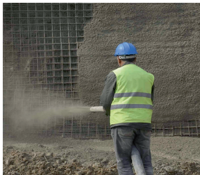
Рис. 3. Торкретирование бетона на вертикальную плоскость по металлической сетке Fig. 3. Concrete shotcreting on a vertical plane over a metal mesh
